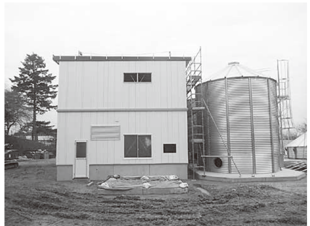
飼料用米加工施設(建設中の写真)
