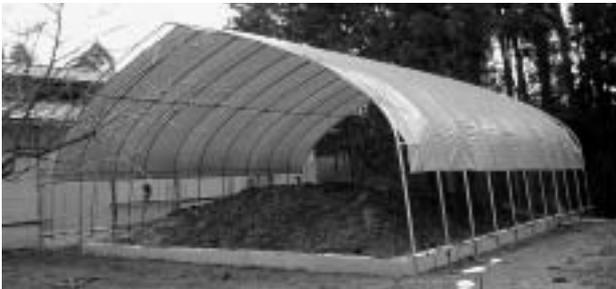
堆肥盤に低い側壁を設け①と同様にパイプハウスを附設したものです。側壁があるため排汁等の流出が抑えられる構造とはなりますが、堆肥そのものは高く堆積することはできません。高く堆積した場合、パイプの間から外部に漏出する恐れがありますので、それに対する対策が必要となります。
