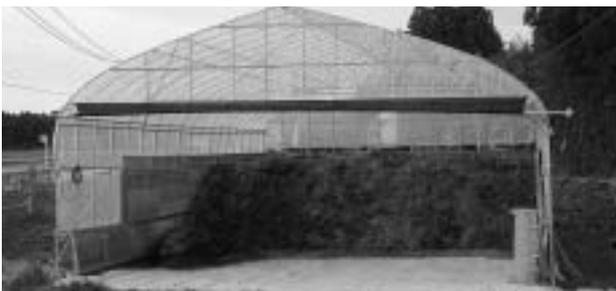
この事例は50 cm程度のコンクリート製側壁の上部にコンパネで側壁を足したものです。側壁を高くしたことにより、堆肥舎そのものの容積を大きくすることができます。ただ、堆肥の動圧に耐える構造とする必要があること、この事例のように屋根が低い場合、作業性が劣ることもありますので、それらへの対策が必要となります。
