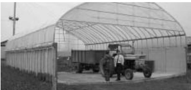
この事例は、T字型のプレキャスト擁壁を組み合わせることで堆肥舎としたものです。プレキャスト背面にはパイプを通す穴が開けてあり、構造的にも強度を持たせたものとなっています。床面はビニールシートを敷き、床土を戻す構造とすることもできます。この施設は県畜産試験場並びに岩出山牧場に設置されています。
