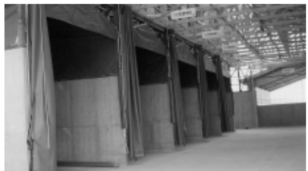
堆肥プラント内風景
